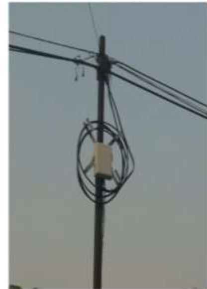
Instalasi Kabel Udara pada Tiang
