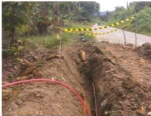
Penggalian untuk Penanaman Pipa HDPE
