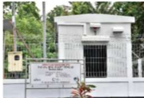
Bangunan Titik Interkoneksi atau Landing Station/Terminal Station
